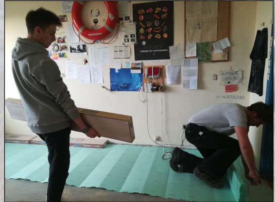
Verlegen der Trittschalldämmung
